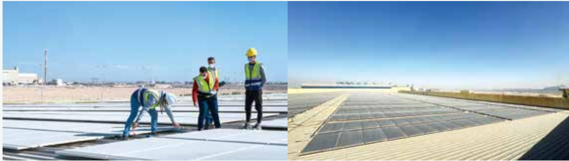
巨石埃及建设光伏发电项目
